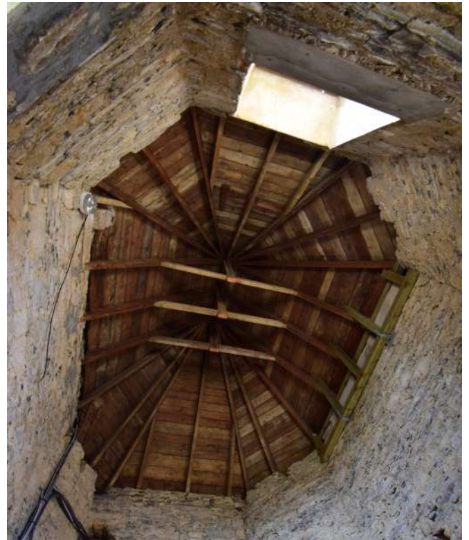
Vue de la sacristie remise dans son état d'origine
